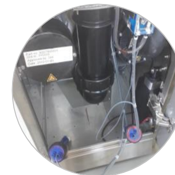
Injection directe d'anticalcaire dans le générateur de vapeur en fin de cycle précédent
