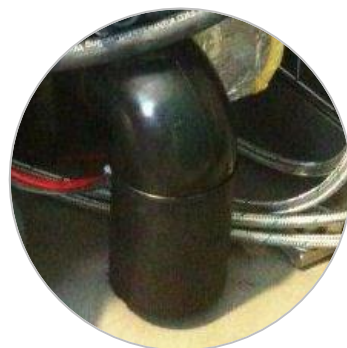
Tous les siphons sont lisses & Pas de raccordement de l'évacuation par manchon souple
