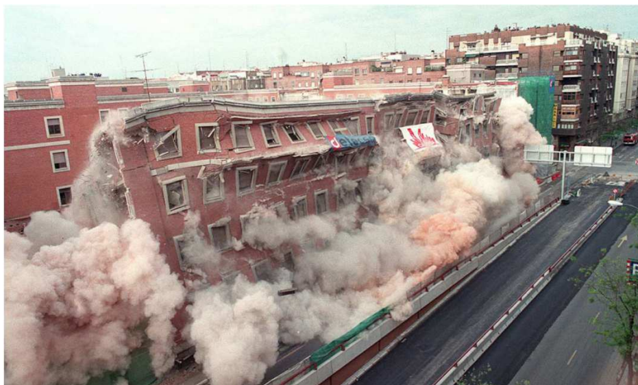
Explosion contrôlée d'un bâtiment de maternité (Source : Agustín Iglesias. Dario medico)
